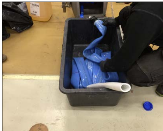
Fig. 10: Fyller strømpe med epoksy
