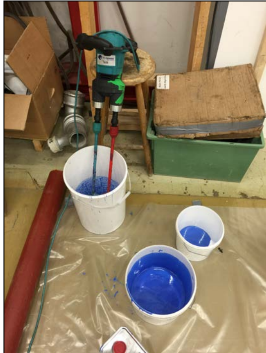
Fig. 9: Blanding av tokomponents epoksy
