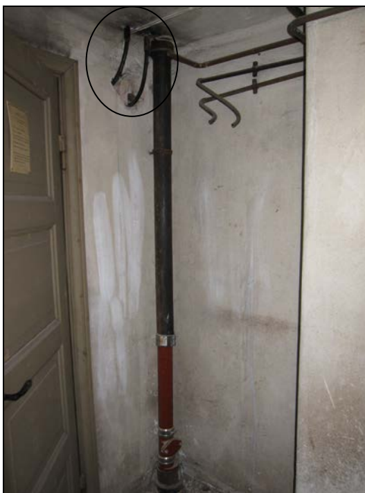
Fig. 84: Vann og avløp til første etasje – sett fra kjeller. Nye vannrør innenfor sirkel
